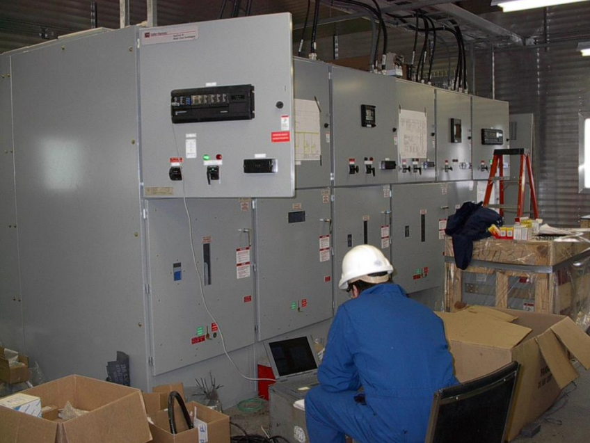
MV Switchgear
